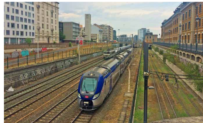
Un train de fret et un TER dans la tranchée de la Guillotière
