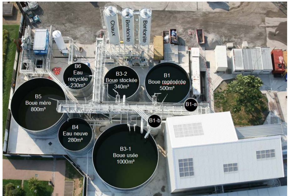
Figure 25 – Usine de traitement des boues (prolongement du métro B à Oullins) © Egis Rail
