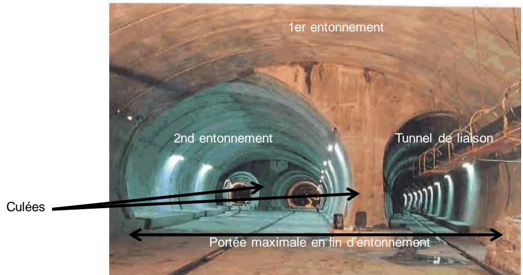
Figure 33 : Ouvrage de transition, gare monotube (EOLE)
