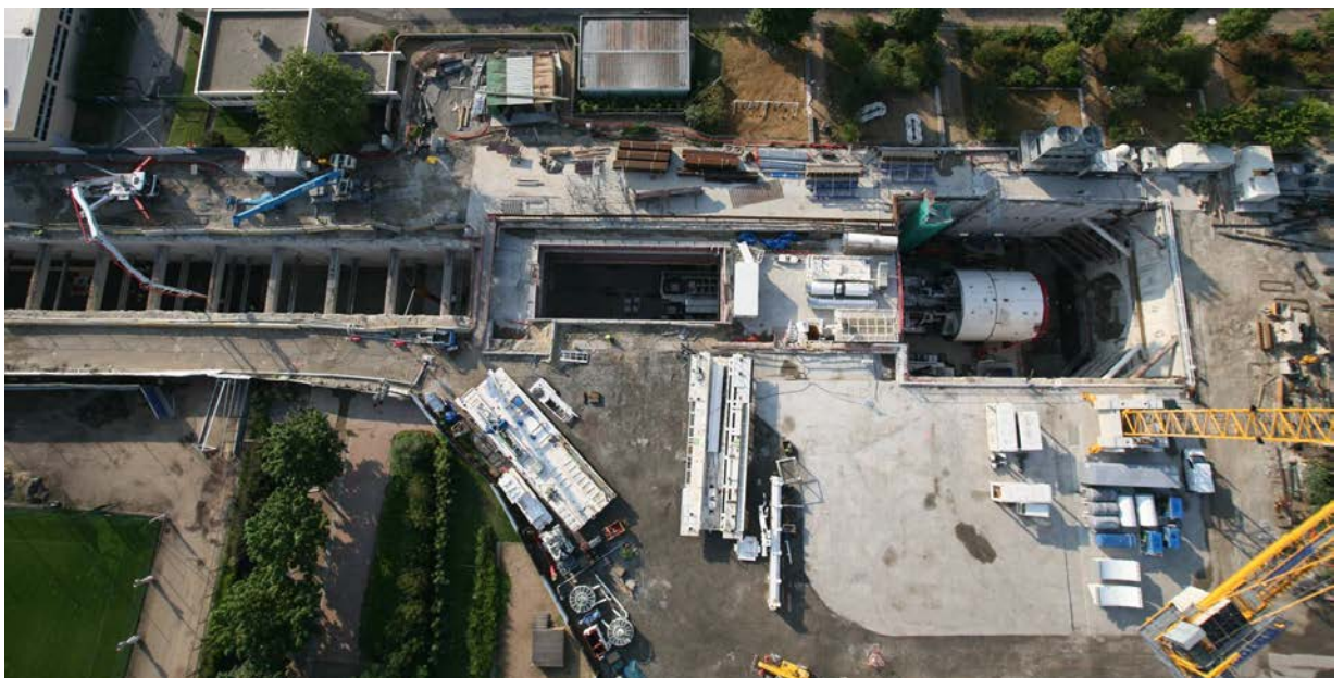
Figure 28 – Puits de démarrage du tunnelier (prolongement du métro B à Oullins) © Egis Rail
