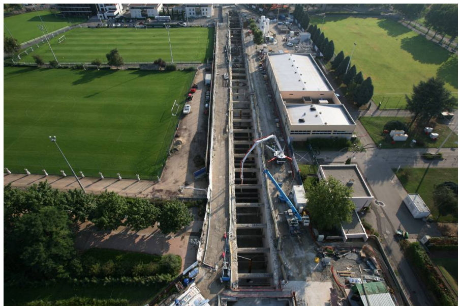
Figure 48 – Tranchées couvertes en cours de travaux (prolongement du métro B à Oullins) © Egis Rail
