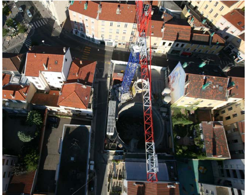
Figure 23 – Photomontage d'un puits de secours, ventilation et désenfumage, puits Gouraud, EOLE © Egis Rail
