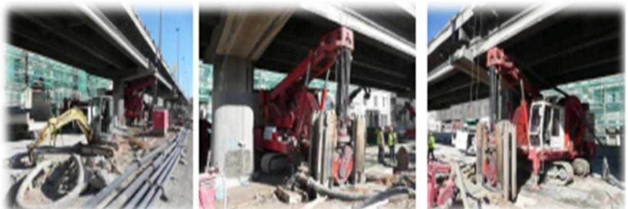
**Figure 35: Réalisation de paroi moulée sous caténares d'alimentation des voies SNCF**
