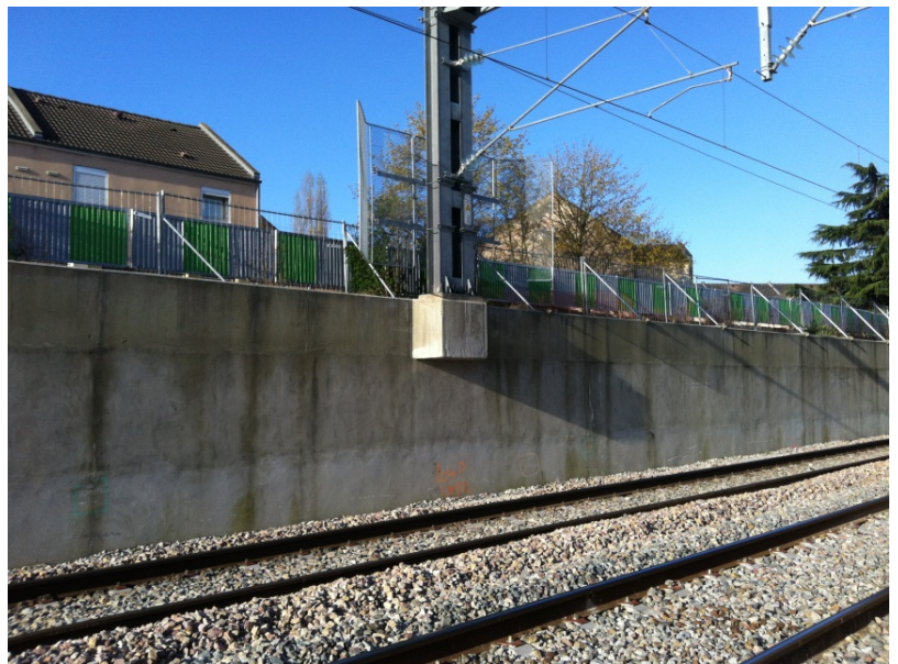
Figure 15 : Massif caténaire combiné à un mur de soutènement.
