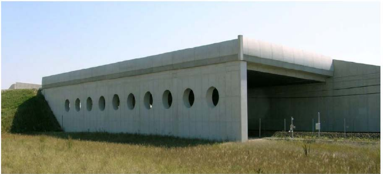
Figure 57 : Exemple d'ouvrage saut de mouton
