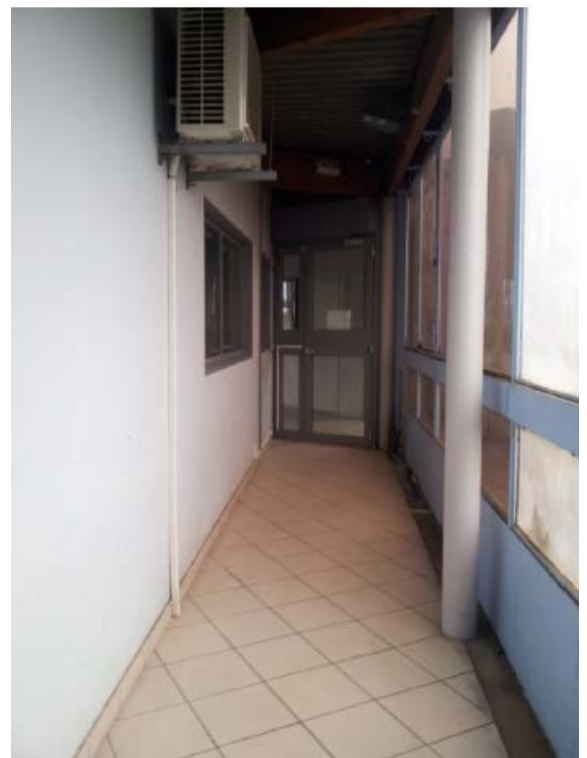
Figure 70 : Vénissieux : couloir d'accès au quai B
