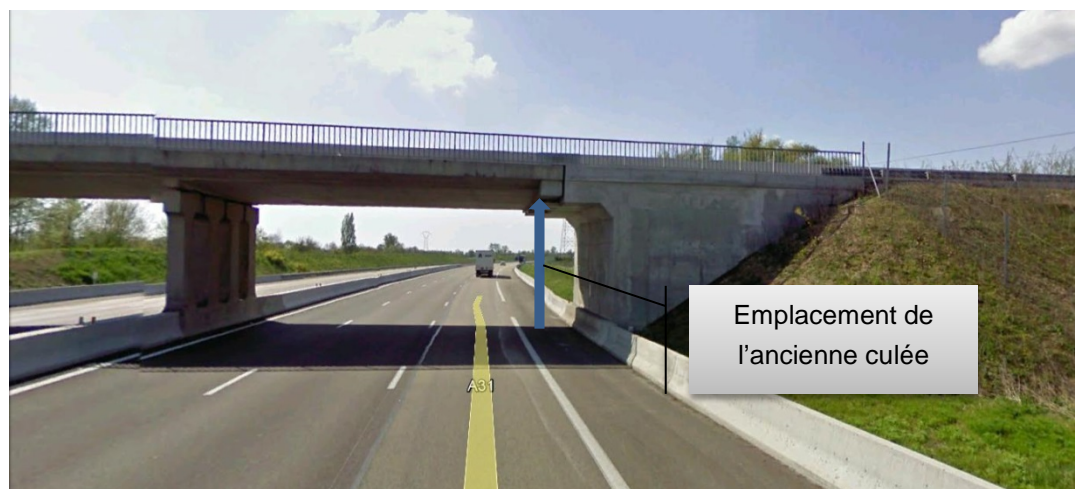
Figure 48 : Exemple d'ouvrage élargi par modification de la culée
