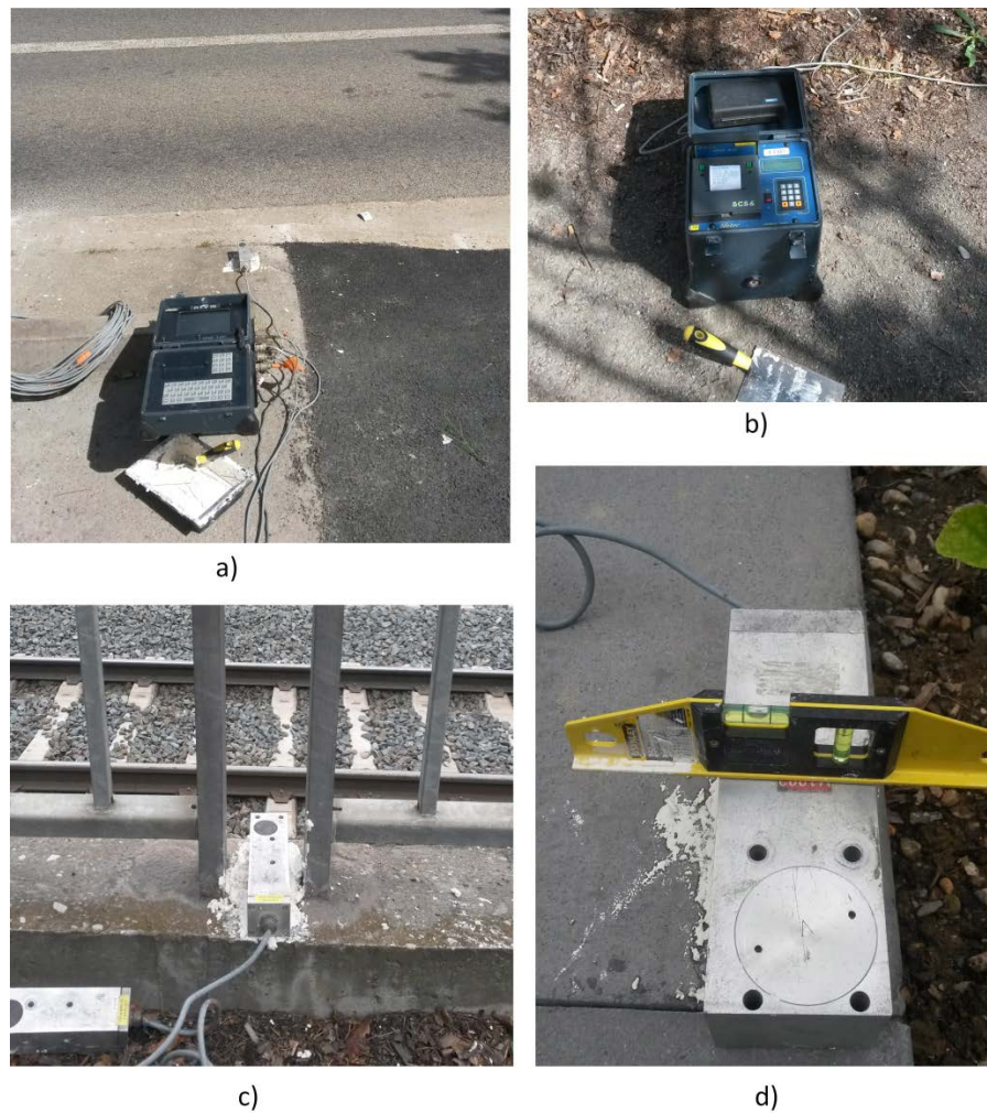
Figure 3: centrale d'acquisition ATV15 (a), centrale d'acquisition SC6 (b), capteurs tri-directionnels 4.5 Hz (c), capteurs tri-directionnels 2 Hz (d)
