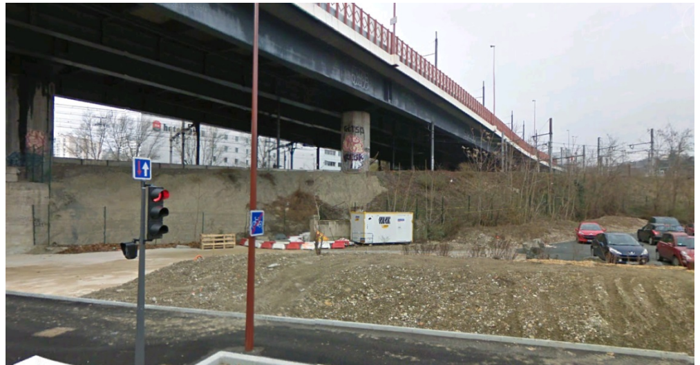
Figure 3-9 : Photo des piles l'ouvrage
