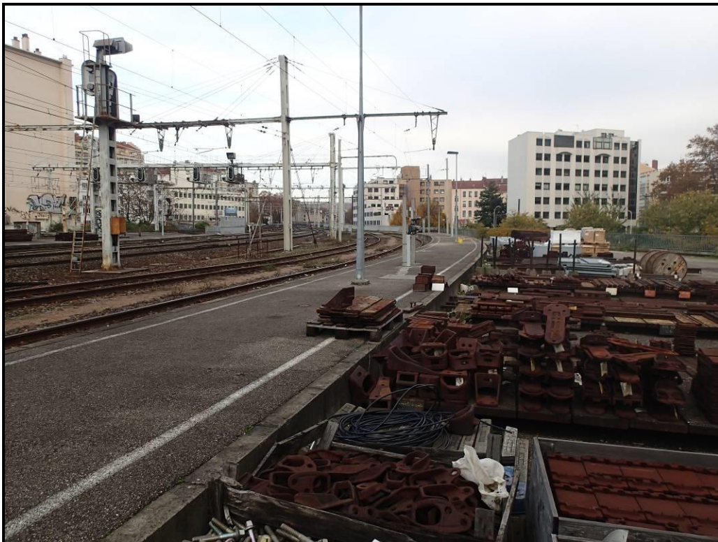
Vue 4 : Idem : vue de détail à proximité des voies
