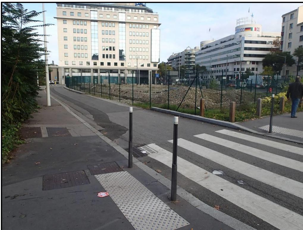
Vue 6 : Emprise puits Nord galerie axiale – Vue Sud/Nord.
